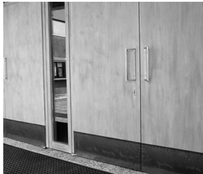
Sanierte Kirchen-Eingangstore – wetterfest und leise
