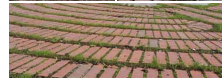
Mit einer Spezialharke wurde altes Gras entfernt, 15 Scheibtruhen Altmaterial wurde abtransportiert, frische Erde mit Grassamen nachgefüllt. Der Erfolg kann sich sehen lassen.
